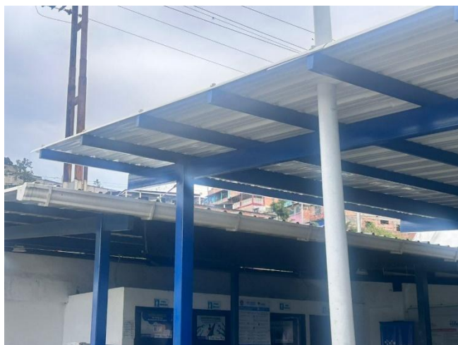
Vista de solape de cubierta entre el módulo 1 y 2 del CEPROD
