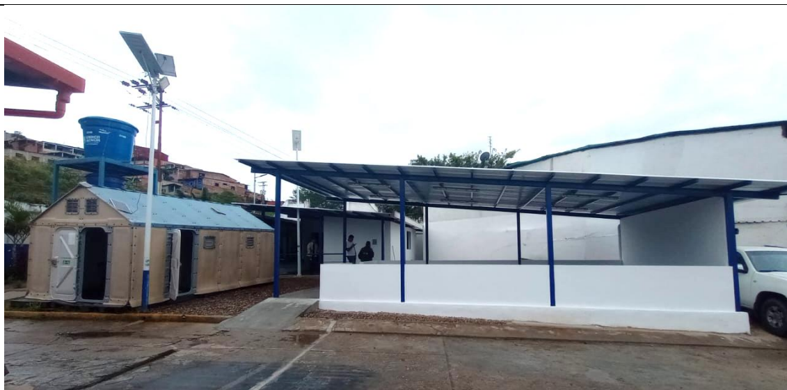
Vista general, del área de usos múltiples del CEPROD
