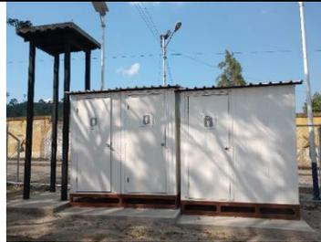
Módulo de cabinas con base para tanque elevado.
