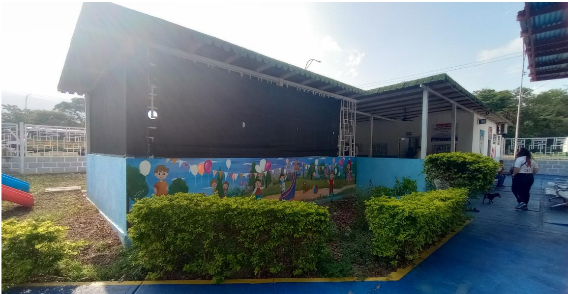
Vista de la fachada principal.
