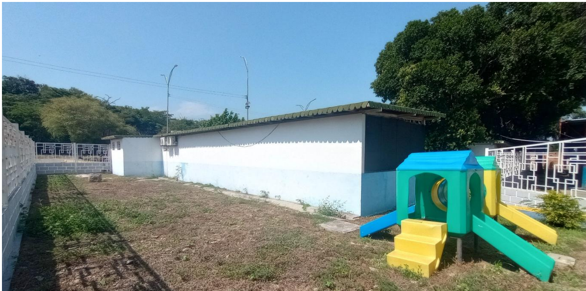
Vista de la fachada posterior.
